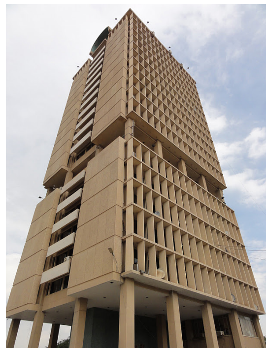
Figura 1. Walter Gropius. Torre de rectoría de la universidad de Bagdad. Fachada sur. Fuente: Fuentes Freixanet, Víctor (2019). Criterios Bioclimáticos y Sustentables en la Arquitectura Moderna. Tomada de http://tochocho.blogspot.mx/2011/11/universidad-de-bagdad-noviembre-de.html
