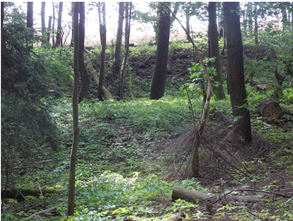
Jižní okraj sesuvu ve střední části sesuvu, projevující se mohutným stupněm v reliéfu.
