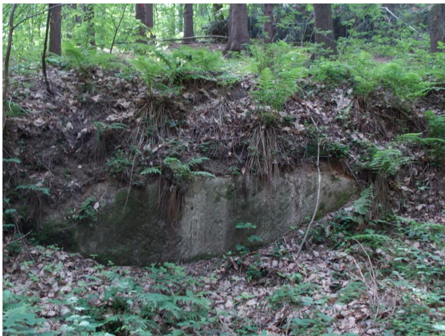
Obr. 16. Kvádrové pískovce pod vrstvou hmotami sesuvu ( DB11 ).
