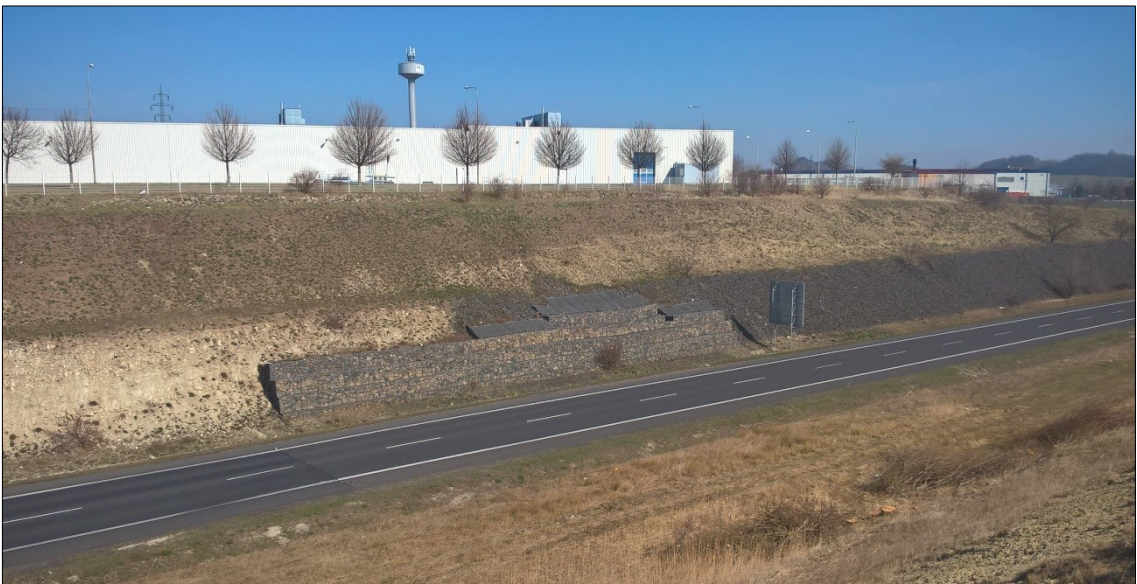
Obr. č. 15: Zárubní stěna v jižním svahu zářezu Louny-prům. zóna (místo průběhu tektonického porušení).
