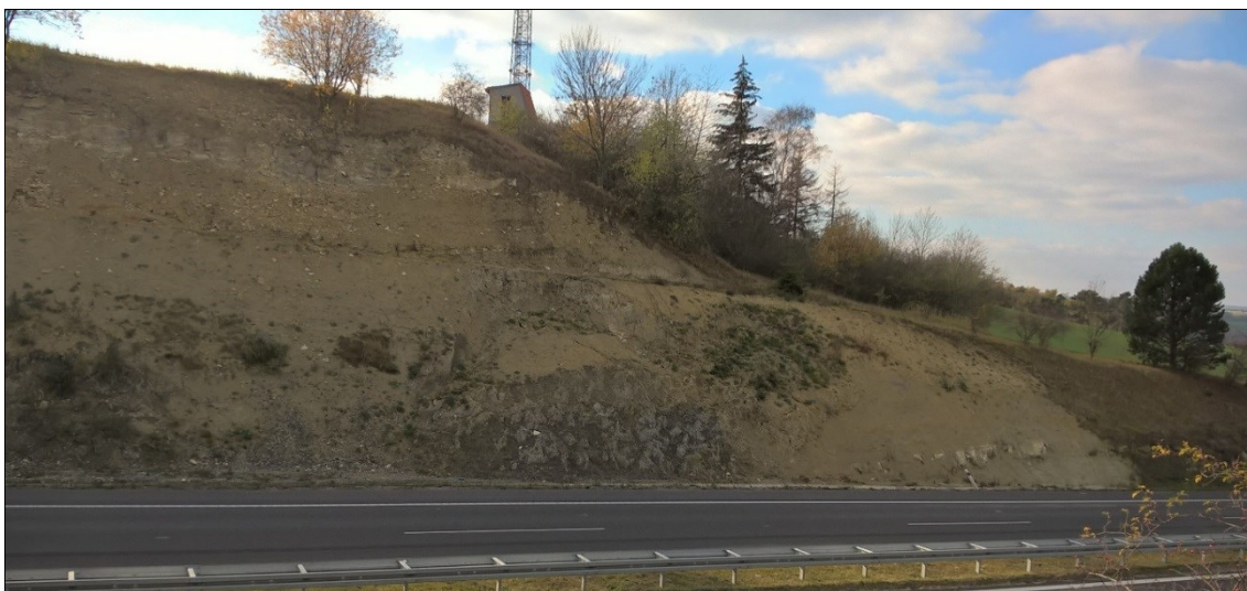
Obr. č. 4: Sesuv v zářezovém úseku Knovíz.
