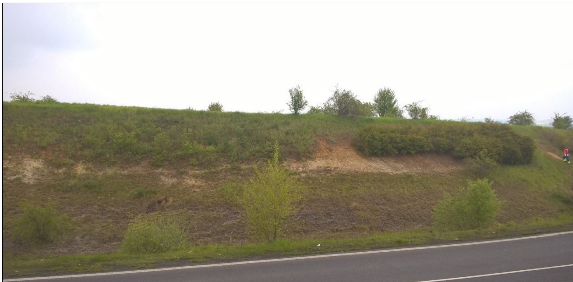
Obr. č. 4: Sesuv v zářezovém úseku Knovíz.
