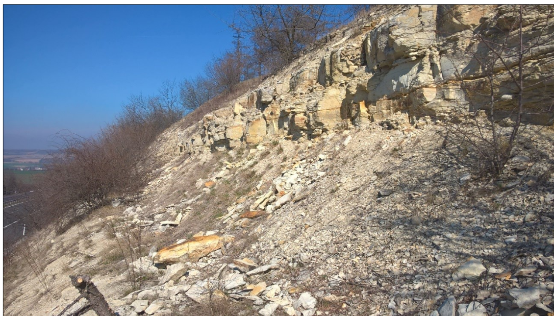
Obr. č. 8: Opadávání úlomků a bloků ze stěny charakteru skalního řícení v zářezovém úseku Knovíz.
