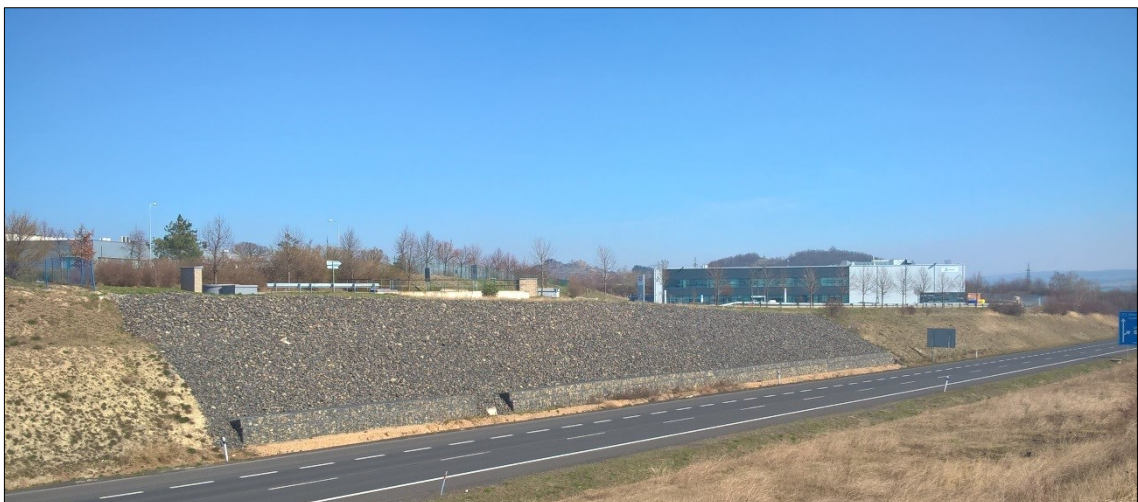
Obr. č. 6: Místo archivní svahové deformace v zářezovém úseku Louny-prům. zóna.
