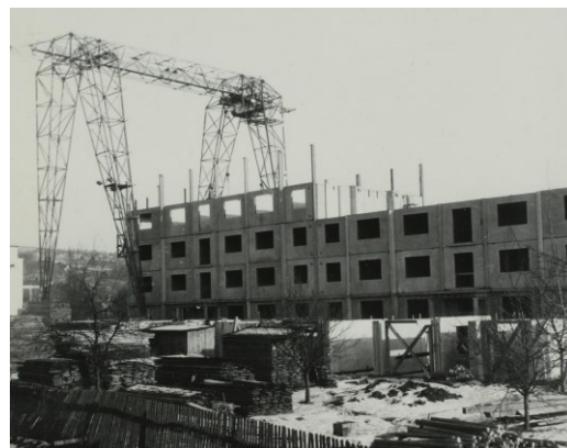
15. Hynek Adamec, Bohumír Kula, realizace prototypu panelového domu G40, 1954. (Krajská galerie výtvarného umění ve Zlíne)
