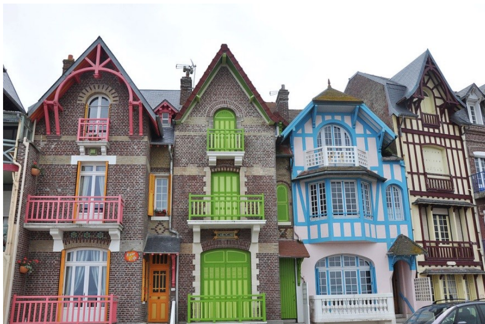
Obr. č. 8: Fasády domů v Mers-les-Bains. Foto: Philippe Alès
