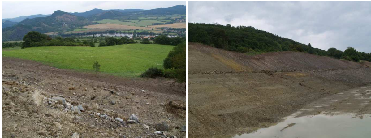
Obr. 5: Terénne elevácie fosilných blokových deformácií pod estákádou Prackovice (foto: P. Kycl).
