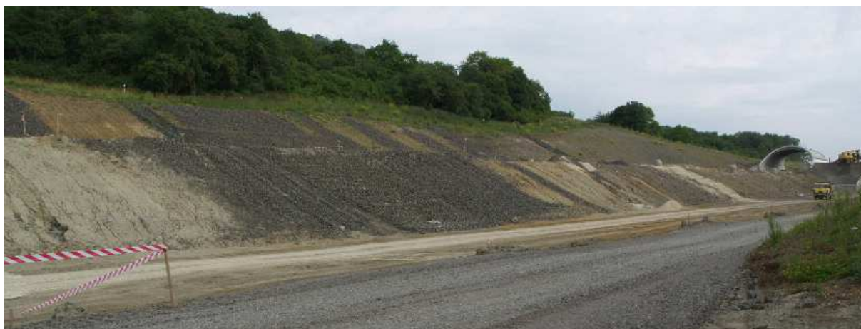
Obr. 12: Pohľad sa upravené svahy zárezov diaľnice D8 (foto: P. Kycl)
