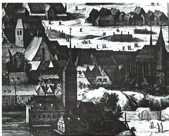
Obr. č. 17: Nepatrný ostrůvek se Šítkovskou věží, vlevo mlýny, r. 1606
