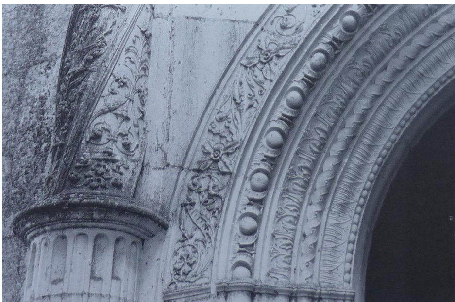
XIV. La Bourgonnière, zámecká kaple, detail portálu hlavního vstupu.
