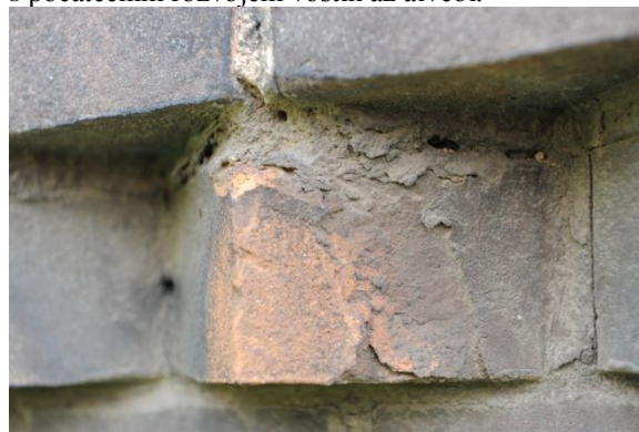
Obr. 20D. Rozsáhlé mnohovrstvé šupinatění s počátečním rozvojem voštin až alveol.
