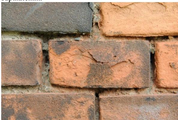
Obr. 20E. Odprsky zpevněné původní vrstvy.
