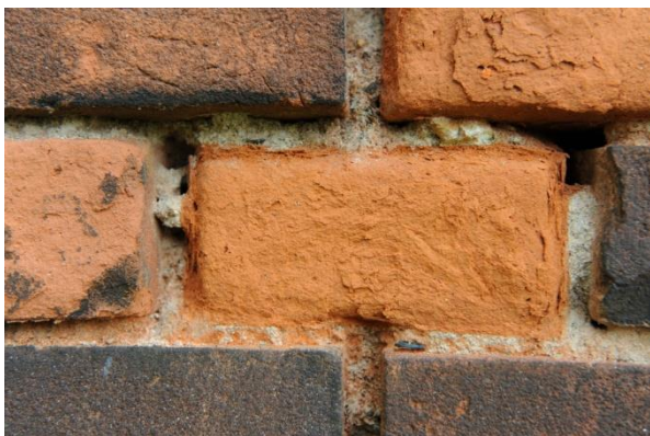
Obr. 20C. Drolivý rozpad doprovázený mnohovrstvým šupinatěním.
