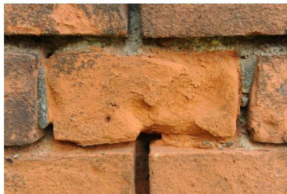
Obr. 20D. Rozsáhlé mnohovrstvé šupinatění s počátečním rozvojem voštin až alveol.
