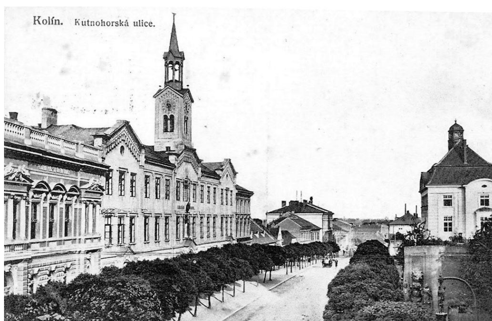
Obr. 2 Budova gymnázia (později obchodní akademie). Pohlednice z roku 1914
