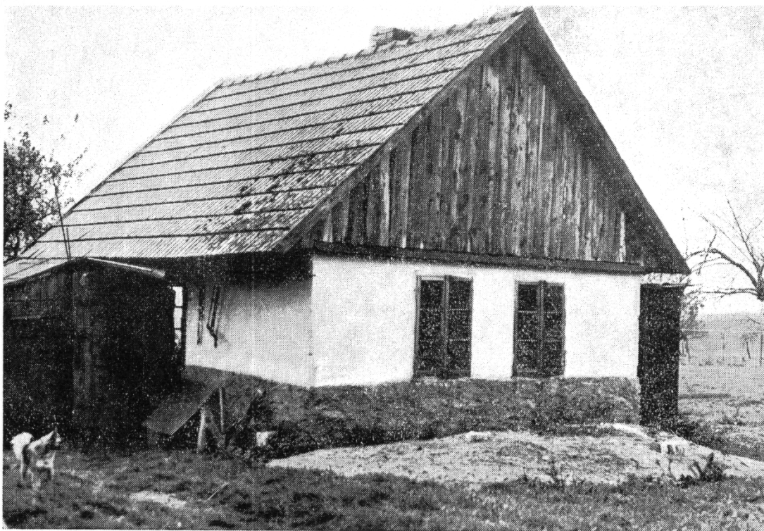
Bretlův „veřtat“ v Zálanech čp. 91
