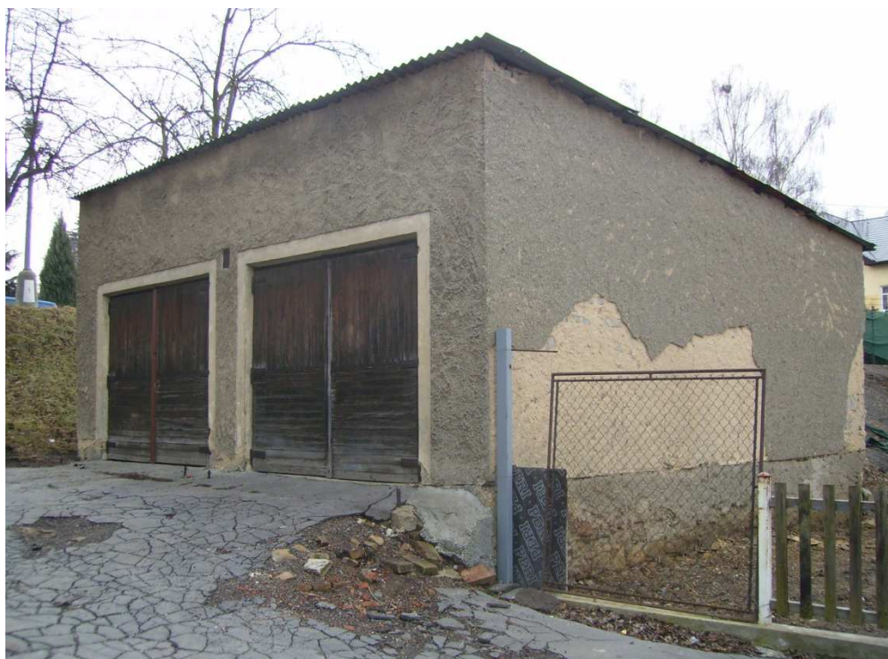
Příloha 12. Přestavěný dům na garáž v Jungmannově ulici, Hořovice
