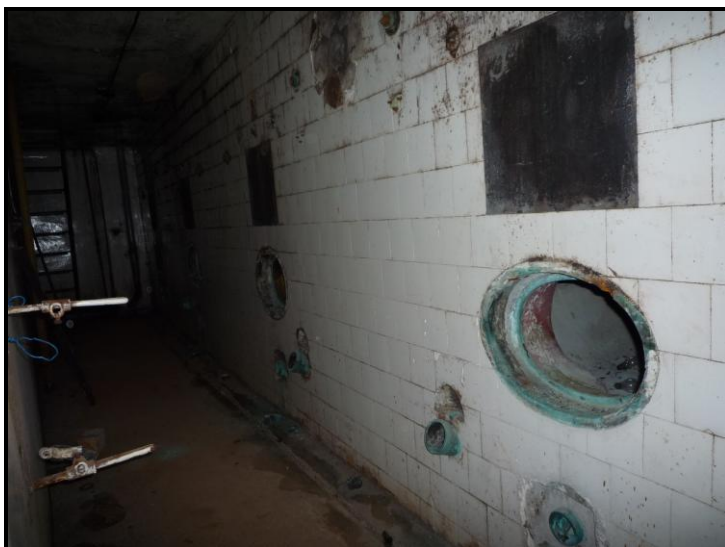
Obr. 42: Železobetonové tanky z roku 1940.
