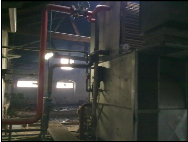
Obr. 40: Štoky během demolice v září 2010.
