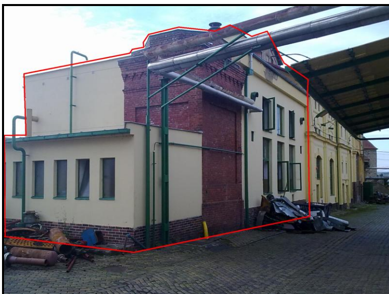
Obr. 34: Kotelna se zděnou patkou strženého komína z roku 1904 v popředí.
