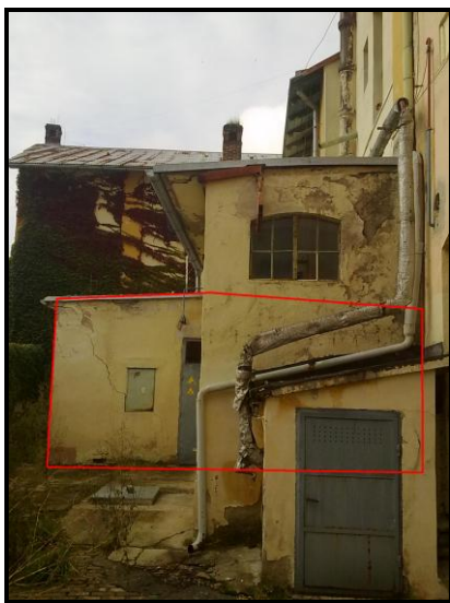
Obr. 36: Výrobna ledu na jižní straně varny.
