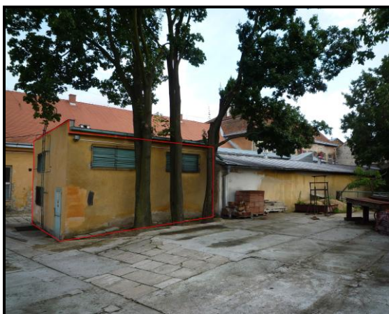
Obr. 46: Trafostanice na severním manipulačním dvoře.
