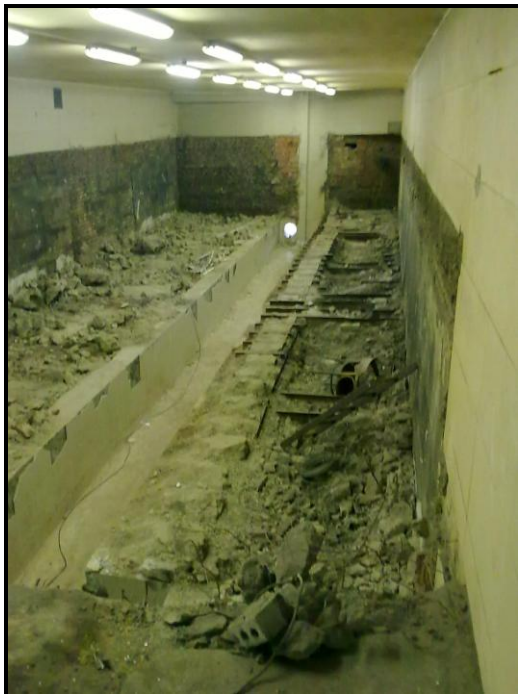
Obr. 38: Spilka po demolici v září 2010.
