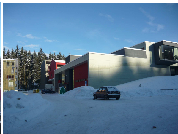
Obr. 5: Apartmánové domy v lokalitě U dolů, v popředí nová budova s restaurací s službami Foto: autorka 9. 1. 2009, Harrachov
