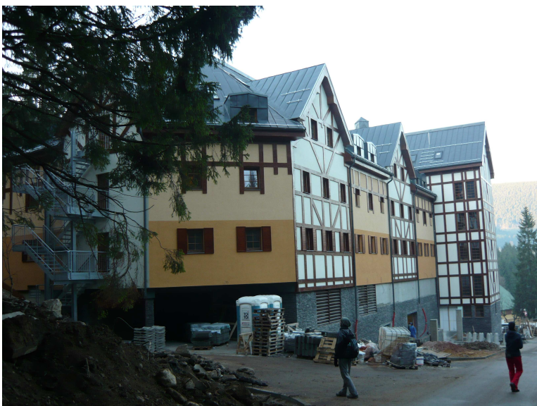
Obr. 19: Projekt „Apartmány pod Sněžkou“ obsahující 63 bytů, místními nazývaný „Megadům“ Foto: autorka 26. 10. 2008, Pec pod Sněžkou
