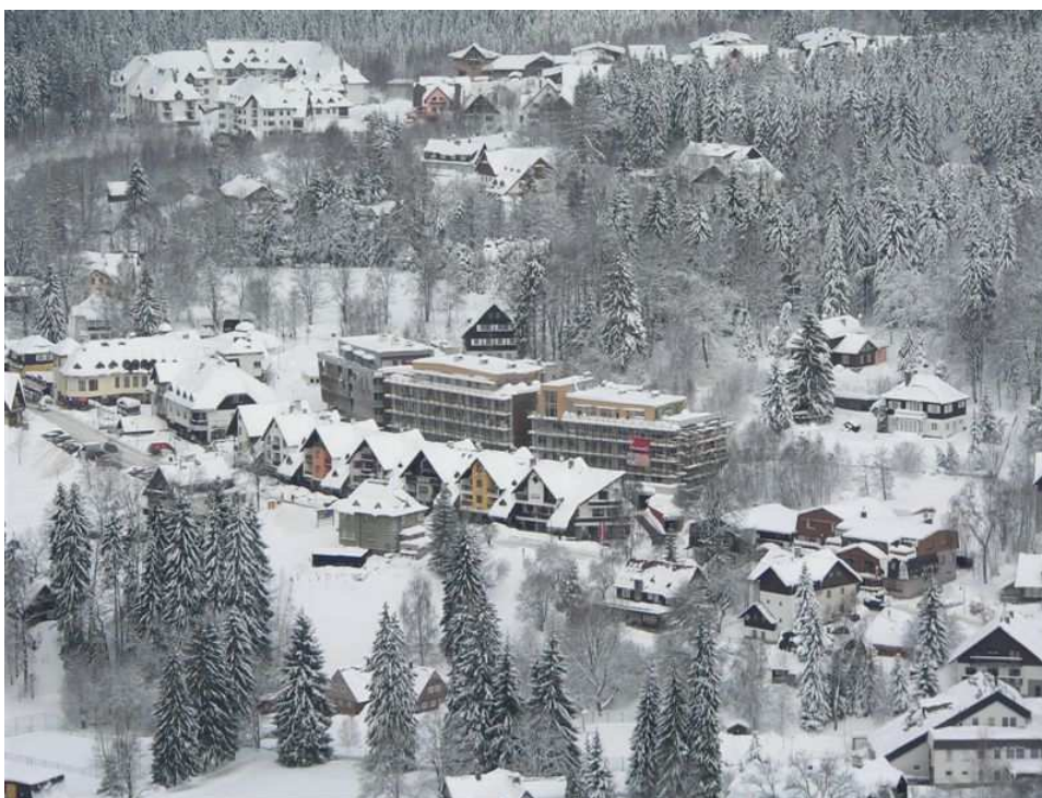
Obr. 1: Narušení přirozené urbanistické koncepce obce Harrachov bytovými domy Čertovka (během výstavby)
