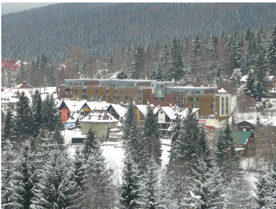
Obr. 2: Dokončené bytové domy Čertovka s velice svéráznou architekturou a neproporcionální velikostí ční nad první řadou domů lemující hlavní ulici obce Harrachov
