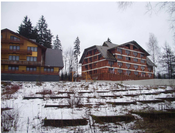
Obr. 8: Nalevo I. etapa a stavba II. etapy projektu apartmánových domů na Sachrově kopci Foto: autorka 7. 1. 2007, Harrachov
