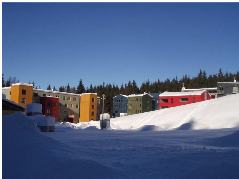
Obr. 3: „Sídliště“ barevných apartmánových domů v lokalitě zvané Ados či U dolů, v současnosti je již tento výhled zastíněn novou budovou s bowlingem, restaurací a squashem Foto: autorka 2. 2. 2006, Harrachov
