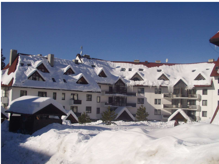
Obr. 11: Jedny z prvních bytových domů v Harrachově v lokalitě V borovicích původně určené k trvalému bydlení Foto: autorka 2. 2. 2006, Harrachov
