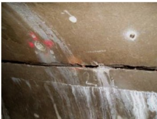
5-17 (vlevo) trhlina v betonovém ostění (foto: Cigler a Follprecht 2007)
