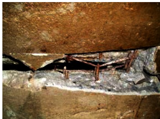
5-17 (vlevo) trhlina v betonovém ostění (foto: Cigler a Follprecht 2007)
