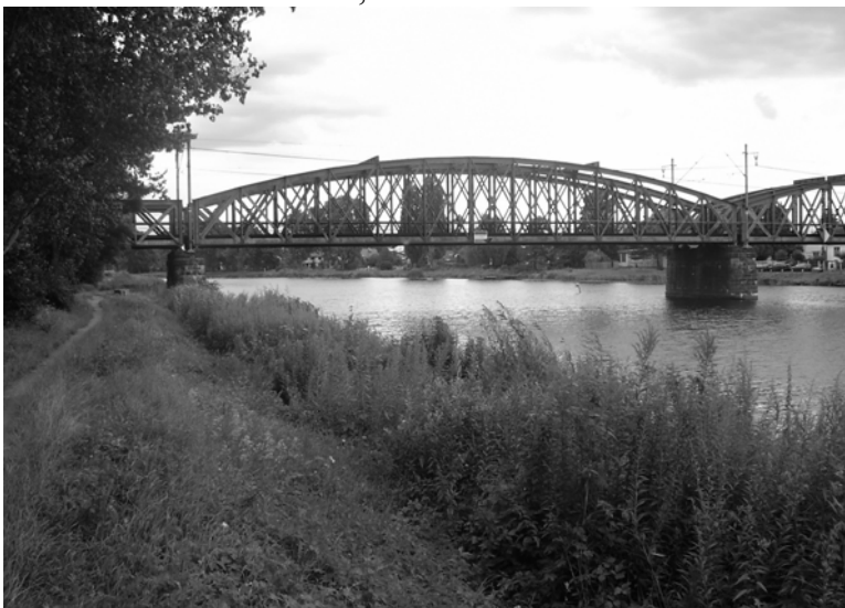
Obr. 21: Železniční most, Čelákovice 2008
