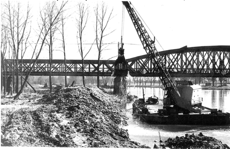
Obr. 20: Zaslepování pravého labského ramena, Čelákovice 1937
