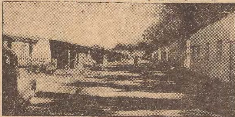
VIVIENDAS DE EMERGENCIA EN SAN JUAN ASPECTO DE LAS nuevas viviendas de emergencia, recientemente habitadas mientras se prepara la reconstrucción de la ciudad de San Juan
