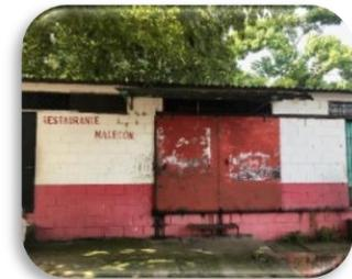
Al costado derecho de la fachada se ubican tres locales cuyos accesos representan un riesgo, por la falta de barandales de protección y gradas apropiadas debido a los cambios pronunciados de nivel del terreno, las graderías existentes de concreto están deterioradas. Se ubica un local comercial
