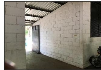
Paredes exteriores e interiores de bloque sisado de 15 cm de espesor, con aplicación de pintura color blanco y rojo
