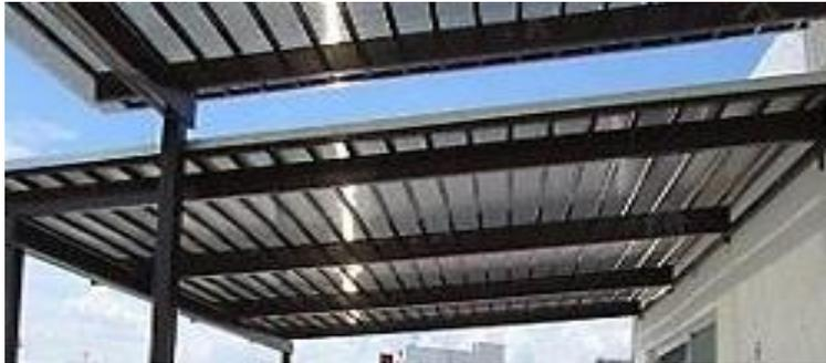
IMAGEN 95. Techo de lámina de policarbonato
