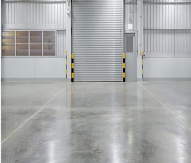
**IMAGEN 98.** Ilustración sobre piso de concreto pulido
