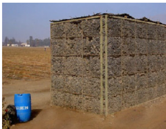
Creatividad en la implementación de las buenas prácticas agrícolas: Cámara de enfriamiento artesanal, con base en carbón. (Foto: IPEH)
