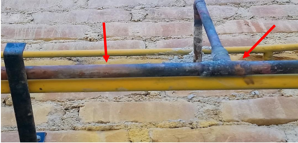
Tuberías presenta corrosión y falta de pintura en toda su superficie y expuestas a cualquier daño externo.
