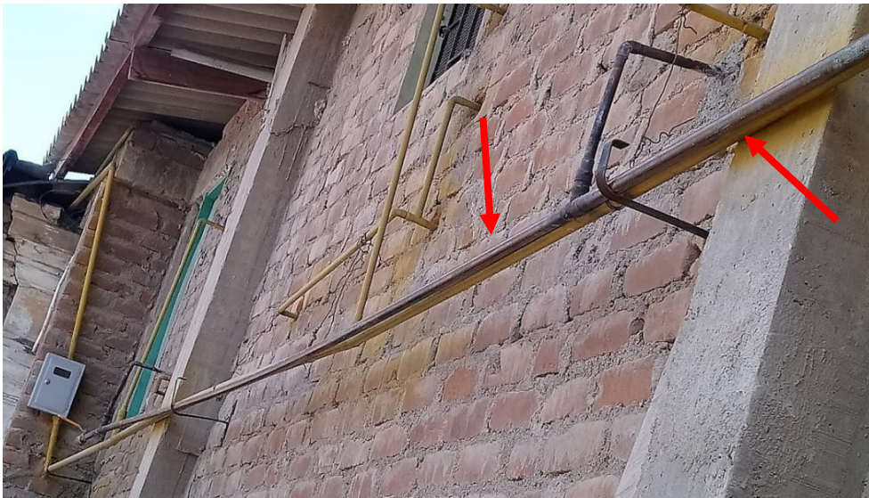
Tuberías presenta corrosión y falta de pintura en toda su superficie y expuestas a cualquier daño externo.
