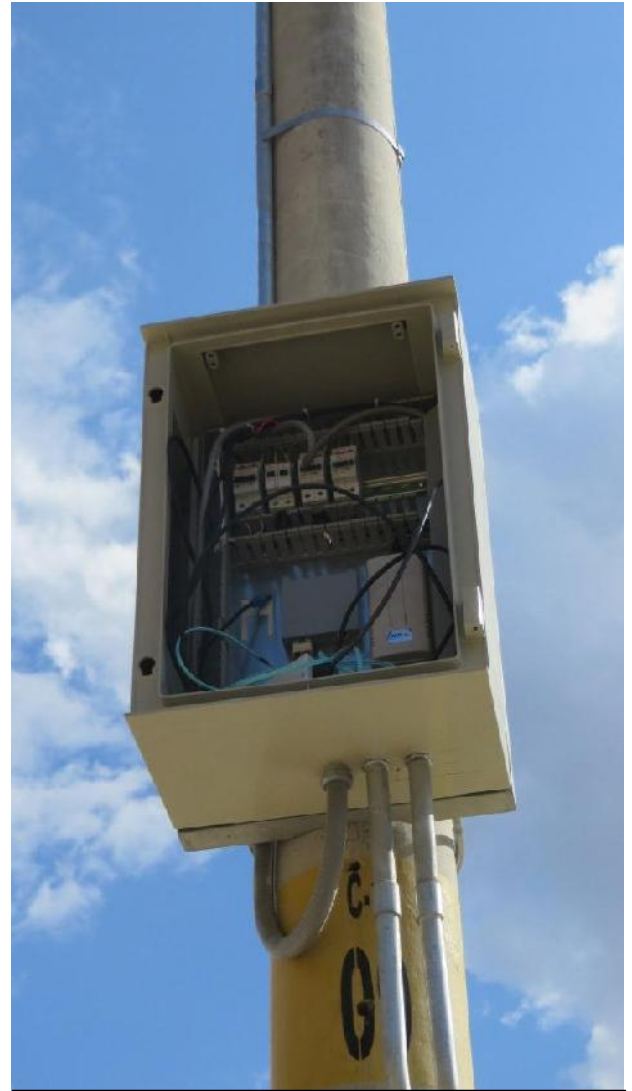
Fig37: Instalación de tablero de alimentación de la cámara
