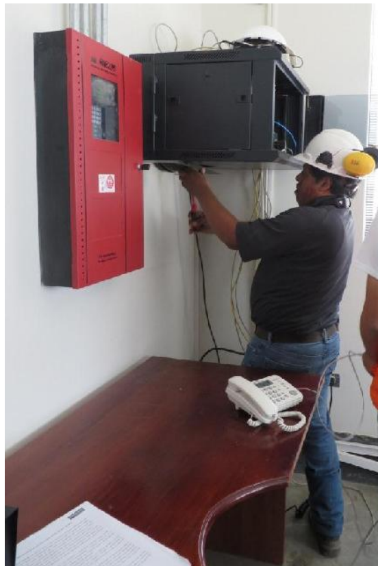
Fig35: Instalación de Switch en rack de comunicación
