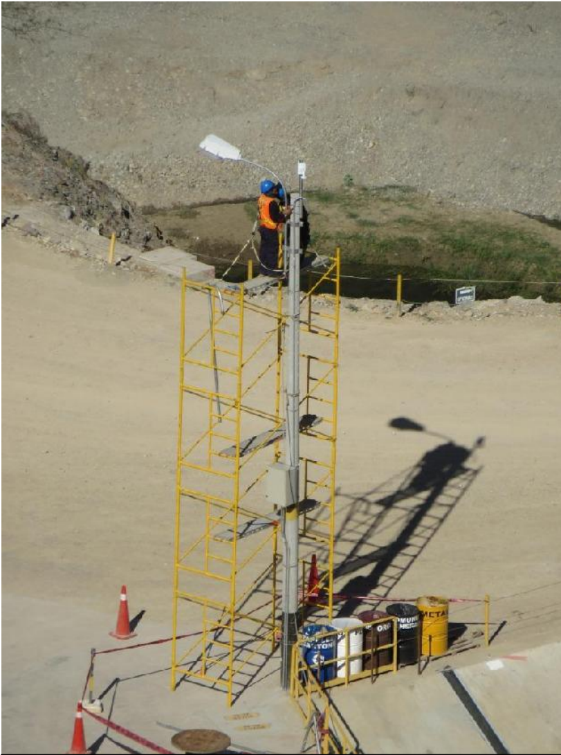
Fig36: Instalación de cámara en Poste
