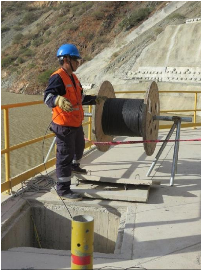
Fig33: Instalación de Fibra Óptica
