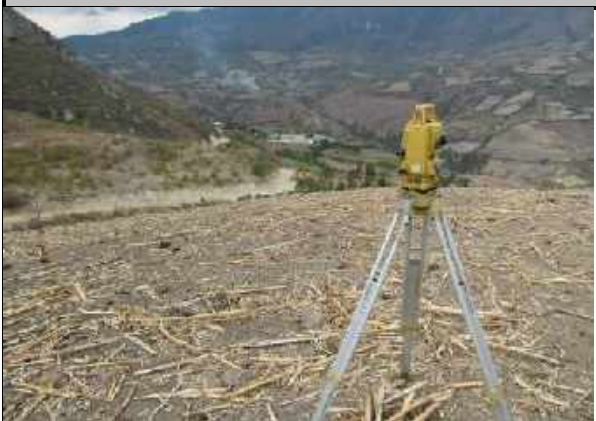
DESCRIPCIÓN FOTO N°: BOTADERO EN EL TRAMO QUIRICHIMA EL SAUCE 38
