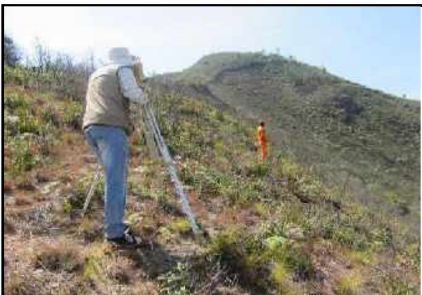
DESCRIPCIÓN FOTO N°: LECTURA DE PUNTOS CON ESTACION TOTAL 27
