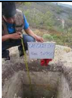
DESCRIPCION FOTO N°: CALICATA 4, KM 3+000 6
