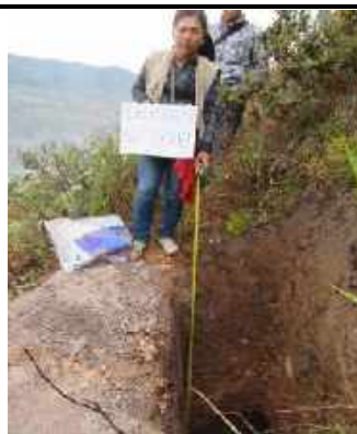
DESCRIPCION FOTO N°: CALICATA 8, KM 7+000 10
