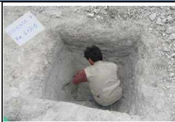
DESCRIPCION CALICATA 7, KM 6+000
