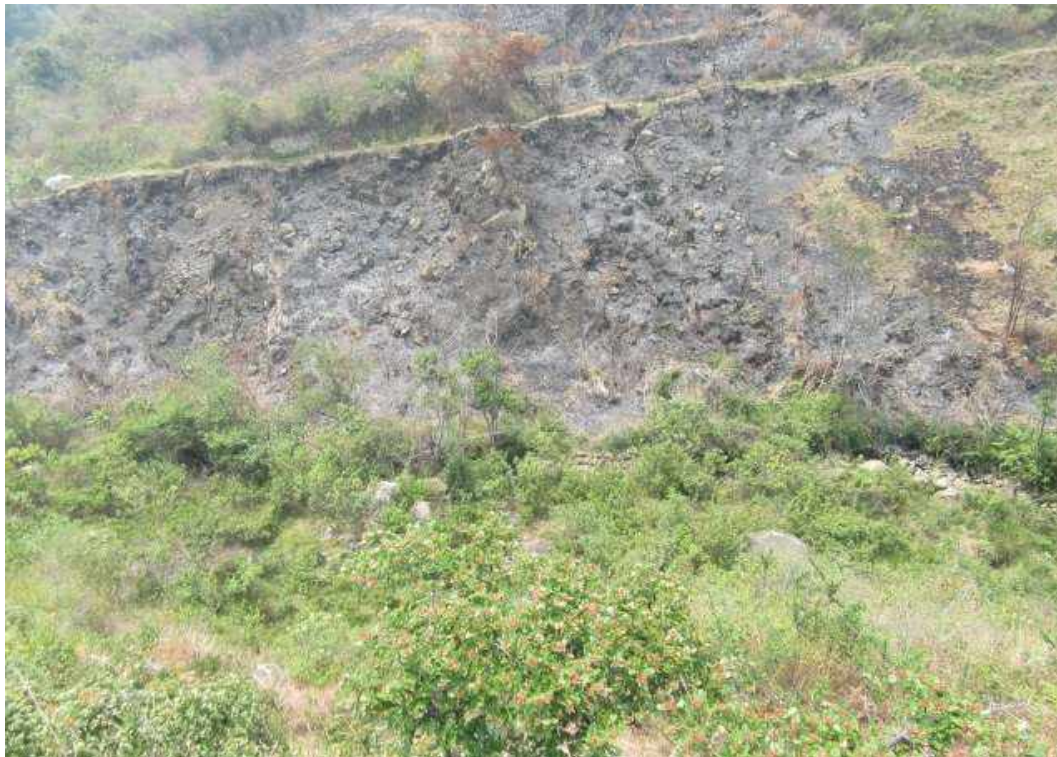
Foto 4.1.11: Material suelto factor de peligro de derrumbes o deslizamientos
