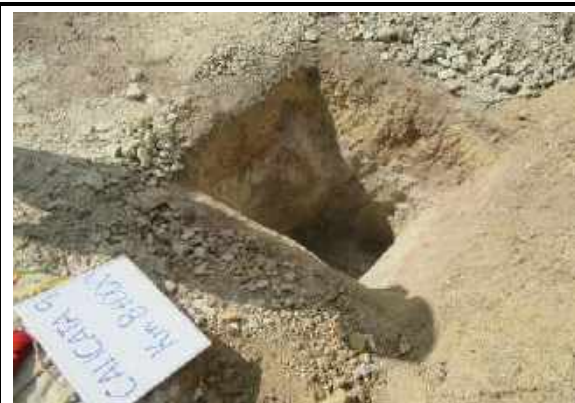
DESCRIPCION CALICATA 9, KM 8+000
