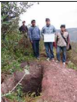
DESCRIPCION FOTO N°: CALICATA 7, KM 6+000 9
