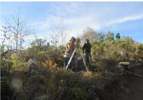
DESCRIPCIÓN FOTO N°: LECTURA DE PUNTOS CON ESTACION TOTAL 25
