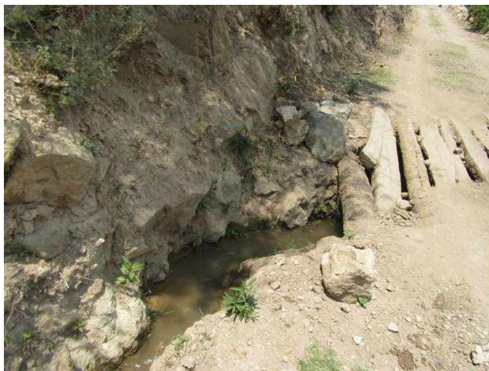
Foto 4.1.16: En las imágenes se muestra la estructura construida por la población ante la necesidad de elemento de drenaje y de paso vehicular.
