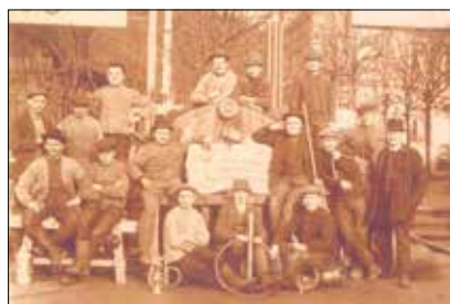
Baustelle der Städtischen Elektrizitätswerke am Pillnitzer Dorfplatz (Foto: Paul Köhne, um 1900). Die Aufnahme stammt aus der Sammlung des Ortsvereins Pillnitz e.V.
