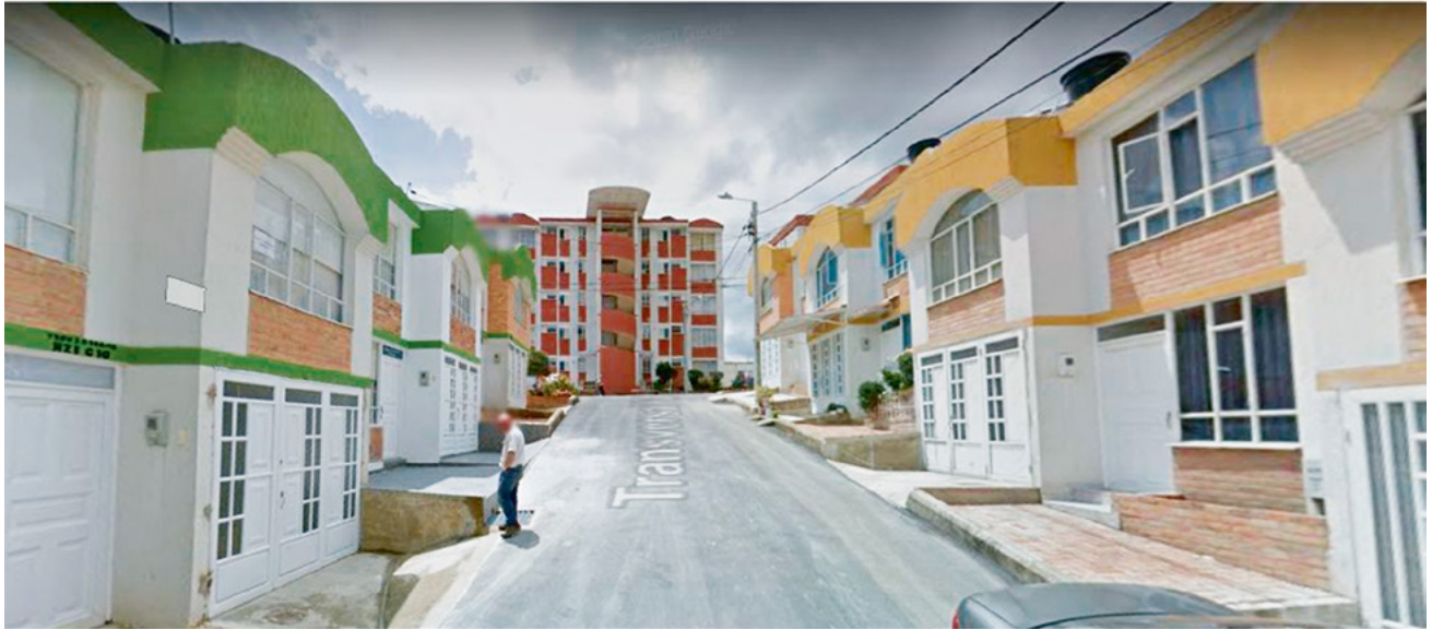
Figura 2. Fachada de casas barrio Colinas del Zué, Tunja.
