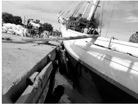
Gambar 4. Fender Pelabuhan Paotere Makassar (Survey)
