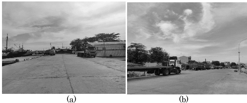
Gambar 10. Kondisi Jalan pada Dermaga Kapal Barang Pelabuhan Paotere Makassar (Survey)
