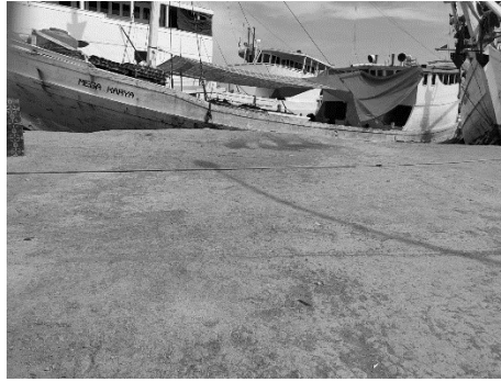
Gambar 3. Apron Pelabuhan Paotere Makassar (Survey)
