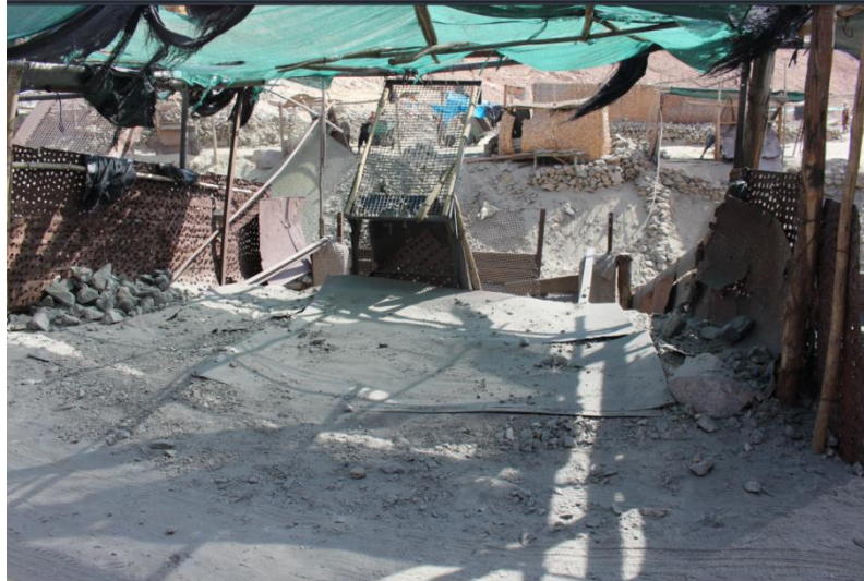
Fig. 9. Zona de chancado y clasificación de mineral
