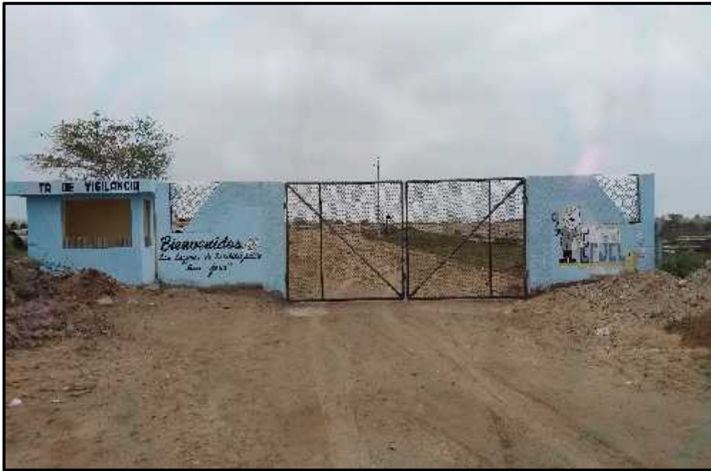
Figura 32. Entrada principal de Lagunas de Estabilización San José - Chiclayo
