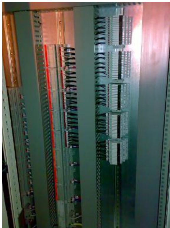
FIGURA 119: FLEX IO Y BORNERAS CON FUSIBLES PARA LAS SALIDAS DISCRETAS.
