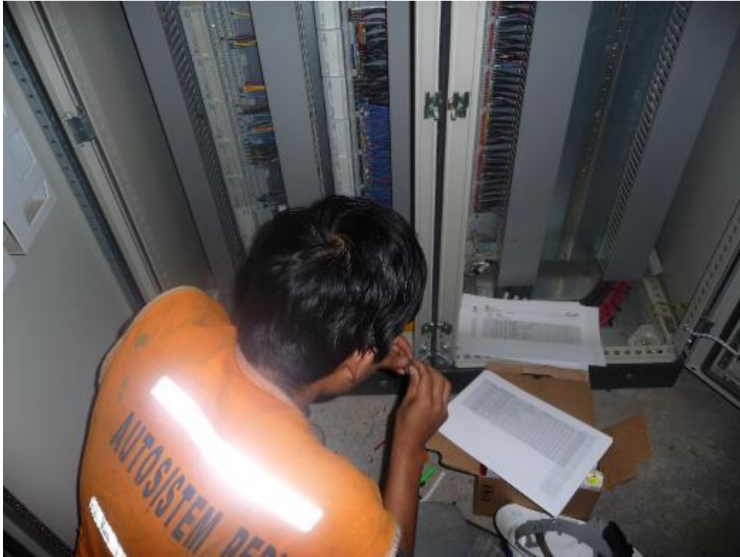
FIGURA 120: REALIZANDO LAS PRUEBAS DE COMISIONAMIENTO. Fuente: Propia
