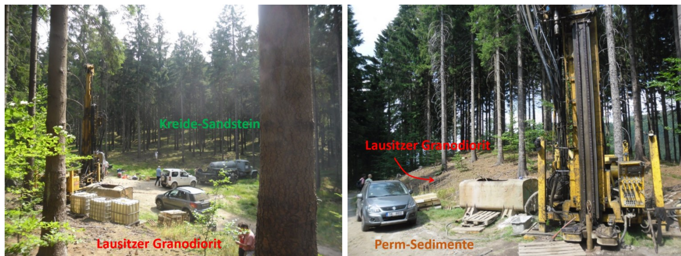
Abb. 39: Standort der Bohrung 6412_L (Lesné) zwischen anstehendem Granodiorit im Norden, den Kreidesandsteinen im Süden und den eingeschuppten permischen Sedimenten.
