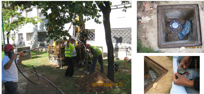
Figure 5.6 Mise en place de l'extensomètre et mesure zéro
