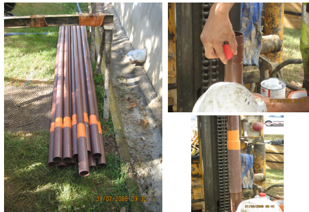
Figure 5.3 Mise en place des inclinomètres
