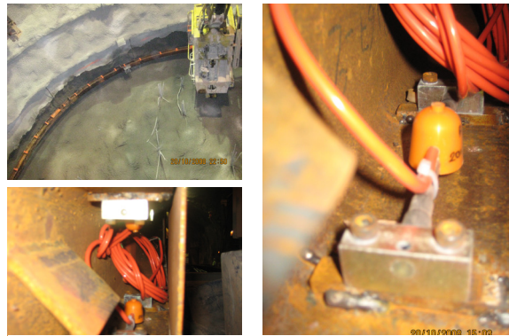
Figure 5.8 Pose du cintre instrumenté et jauges extensométriques
