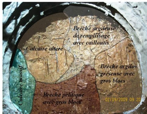
Figura 3.3 Front de taille du tube Sud
