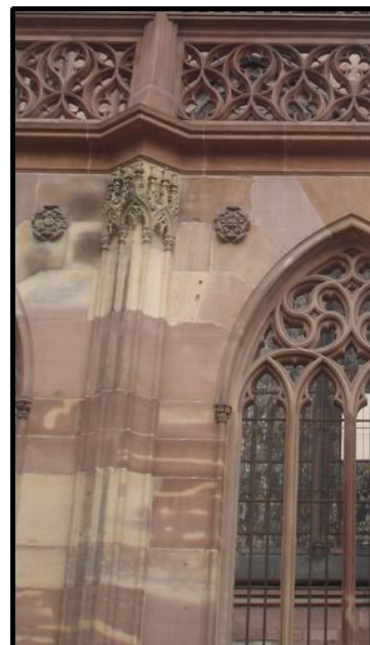
Figure I-3 : Diversité des teintes de grès à Meules (galerie Goetz, flanc sud).
