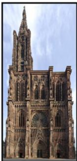
Figure I-1 : Vue de la façade principale de la cathédrale Notre Dame.
