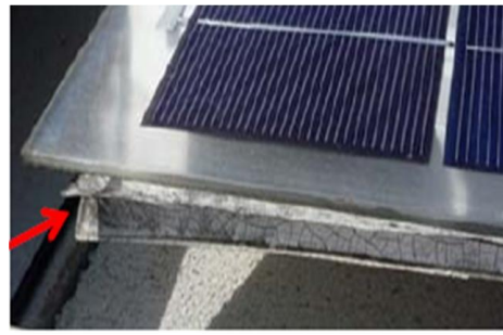
(h) défaut mécanique de la face arrière
