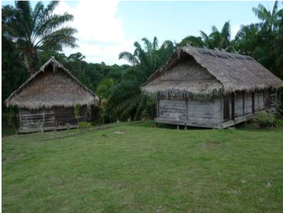
Photo 8 : Une vue des hébergements du Lodge Tolenga
