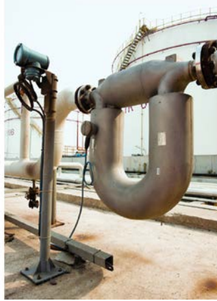
Figure 2.8 : Exemple d'un débitmètre à effet Coriolis de très grandes dimensions
