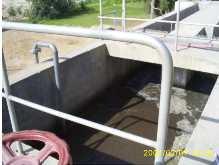
Figure 2.2.1 : Bassin de contact
