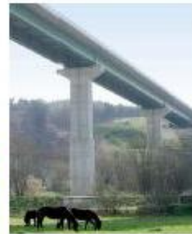
Viaduc du Bec
