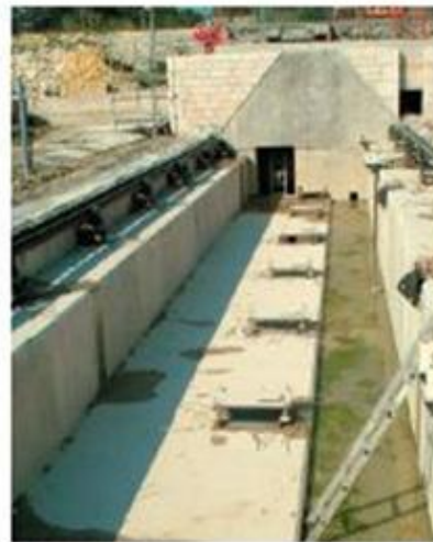
Barrage sur le Choz
