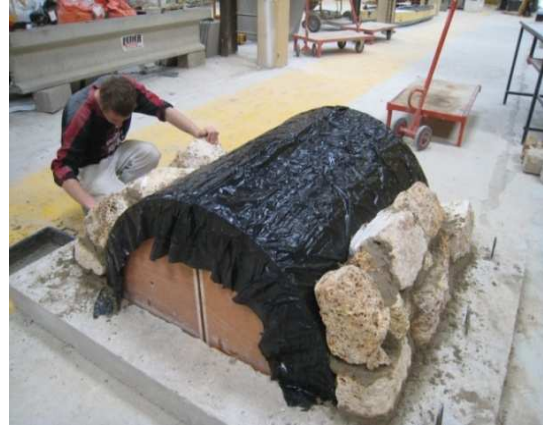
Fig. IV- 6: construction des voûtes
