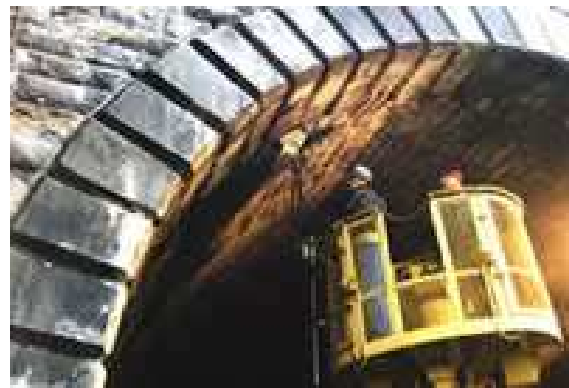
Fig. I- 5 : auscultation par radar géophysique
