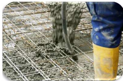
Fig. II- 2: mise en œuvre de béton armé [2]
