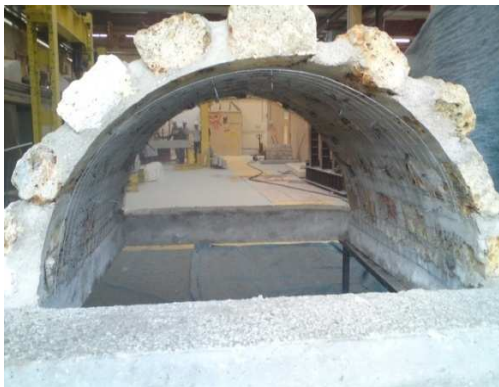
Fig. VI- 24: mise en place des aciers
