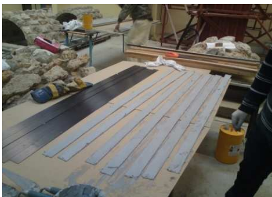
Fig. VI- 4: application de la colle sur les plats
