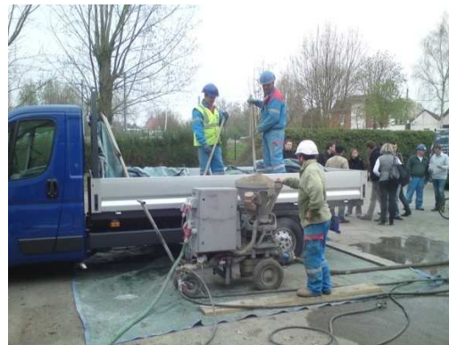
Fig. VI- 25: projection par voie sèche
