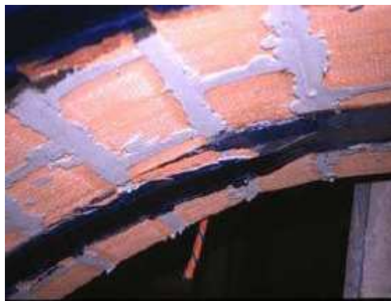
Fig. II- 22 : détachement des fibres
