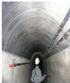
Fig. II- 1: ouvrages renforcées par matériaux composites
