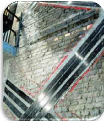
Fig. II- 8 : mise en place des lamelles sur un mur en briques [9]
