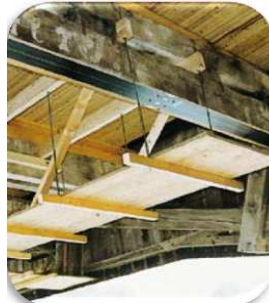
Fig. II- 7: mise en place des lamelles sur une structure bois [9]
