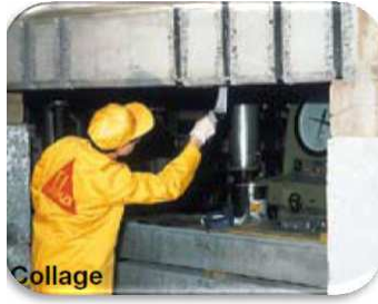
Fig. II- 9 : mise en place d'équerres de renforcement sur une poutre en Té [9]
