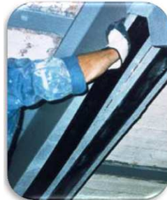
Fig. II- 6 : mise en place des lamelles sur une poutre [9]
