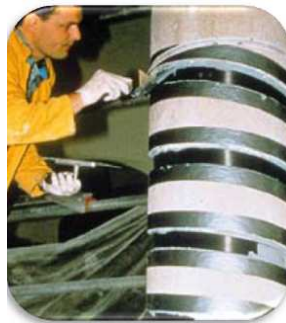
Fig. II- 10: mise en place de lamelles de carbone autour d'un poteau [9]
