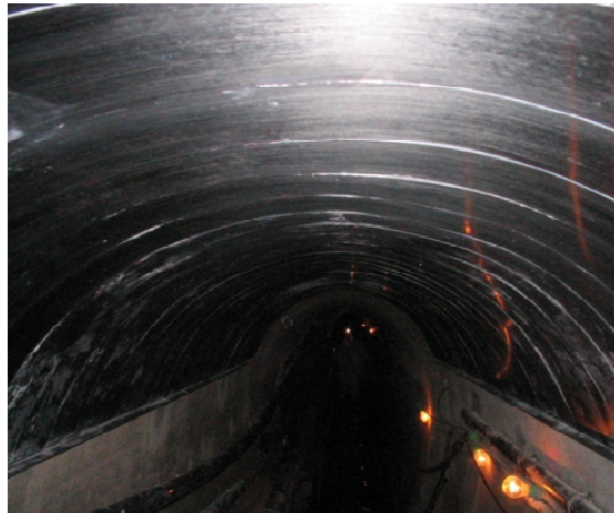
Fig. VI- 1: ouvrages en béton armé renforcées par matériaux composites
