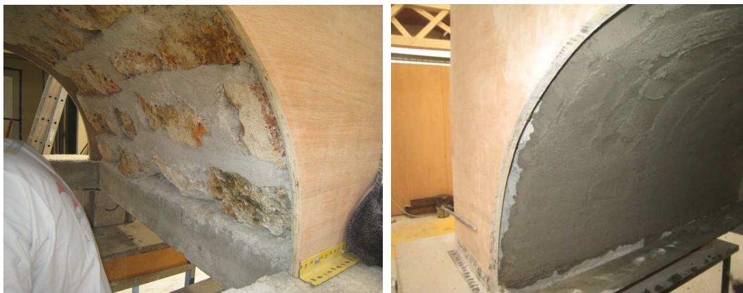
Fig. V- 2: application de l'enduit
