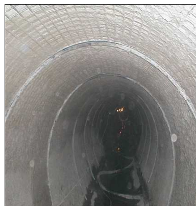
Fig. I- 11 : ouvrage renforcé par béton projeté [21]
