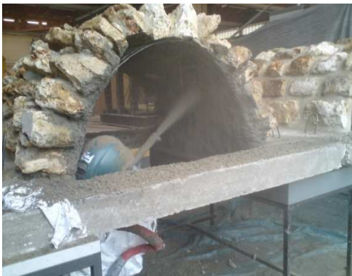
Fig. VI- 29 : projection et voûte finie
