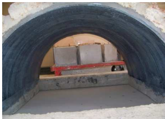
Fig. VI- 9: voûte renforcée par des tissus de carbone
