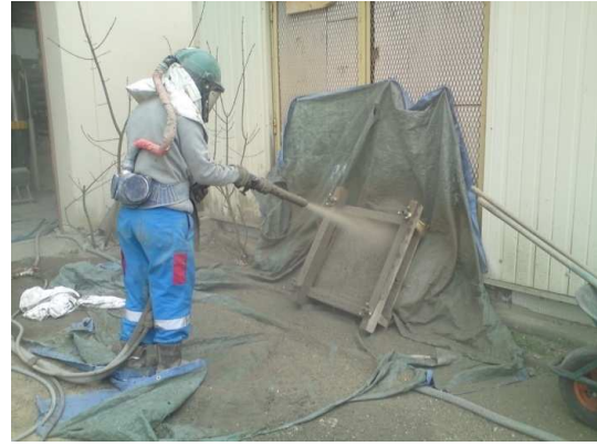
Fig. VI- 26: caisse en béton projetée
