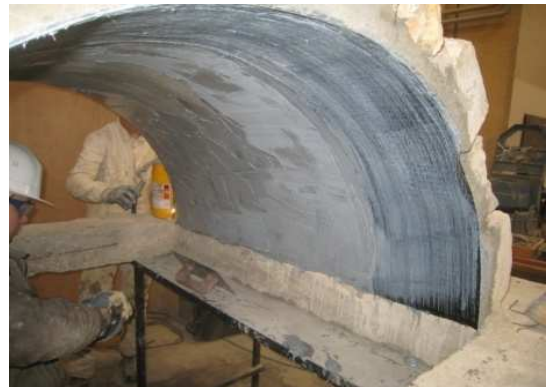
Fig. VI- 8: application de la colle et des tissus sur la voûte
