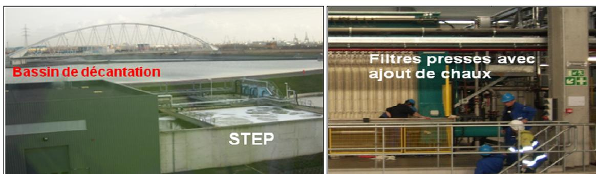
**Figure 2** Bassin de décantation, STEP et filtres presses de l'usine AMORA d'Anvers (Belgique) qui assure la déshydratation, par décantation, filtres-presses, et chaulage des sédiments de type B4 pour la valorisation en butte paysagère, paysagère, avec gestion des eaux de traitement et de stockage.
