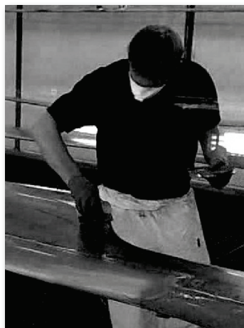
Figure 25 : Imprégnation du mastic bleu
