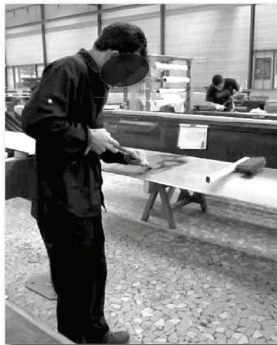
Figure 22 : Déconstruction au grattoir
