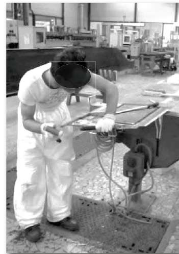
Figure 23 : Déconstruction avec marteau et ciseau
