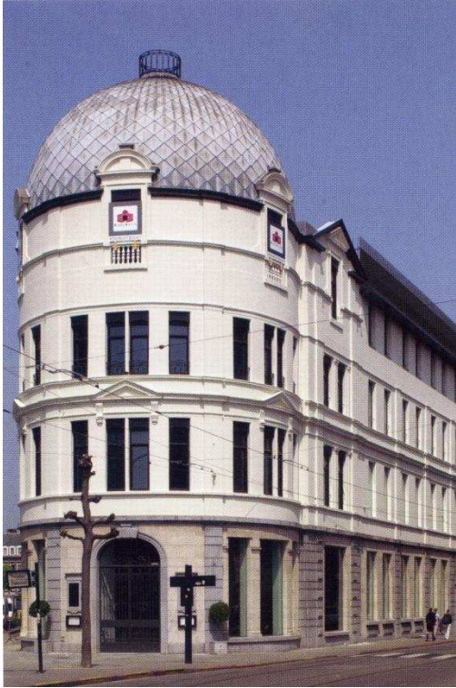
Fig. 3.1 Exterior of the ModeNatie from Nationalestraat.
