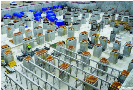
(b) Appuis parasismiques réels, Cahiers, 2011
