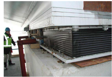
(c) Appuis parasismiques réels, Pecker, 2010a
