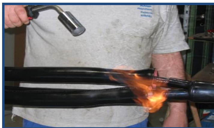
Figure 4. Photographie d'une transition thermo-rétractable en cours de réalisation.
