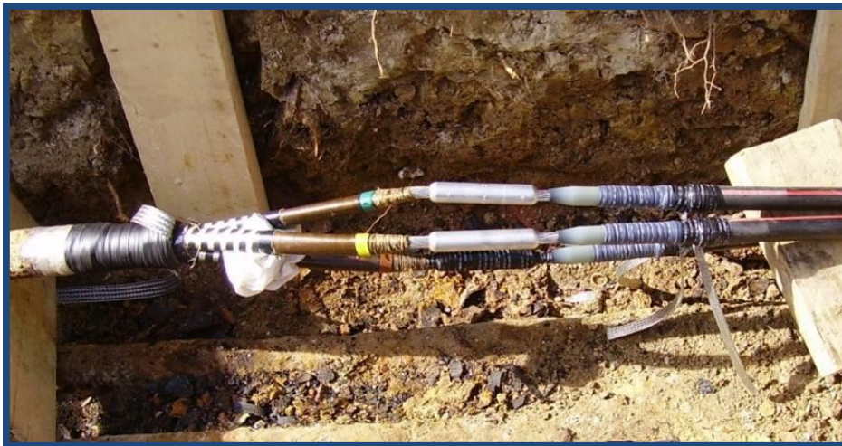
Figure 3. Photographie d'une transition en cours de fabrication.
