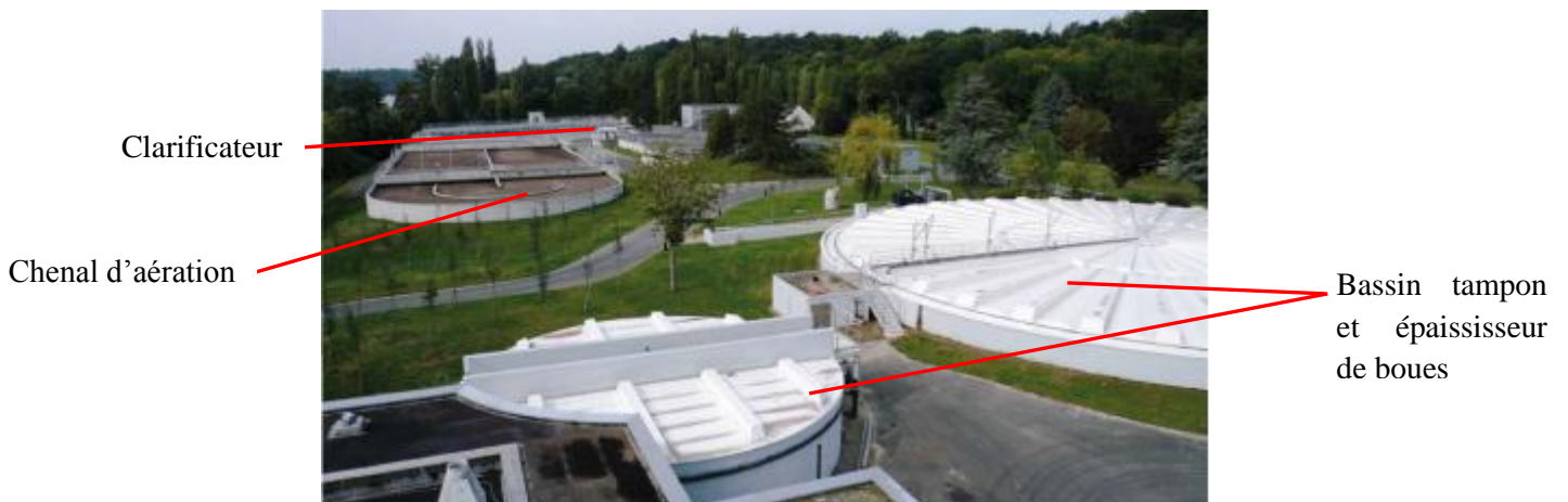
Figure 39 - Vue de la STEP A
