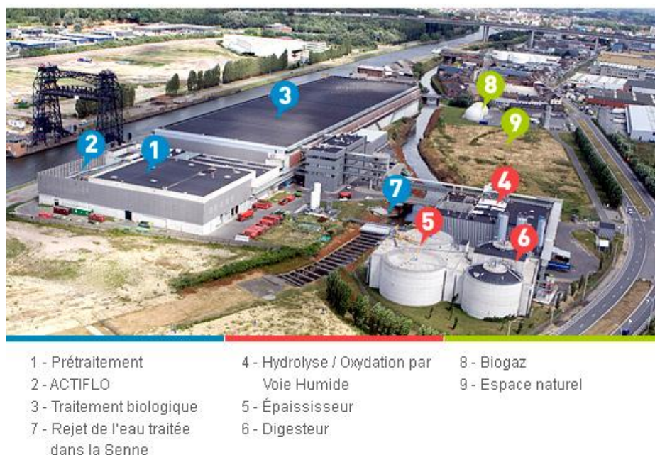
Figure 40 - Vue générale de la STEP B (en bleu : filière eau, en rouge : filière boues, en vert : biogaz)
