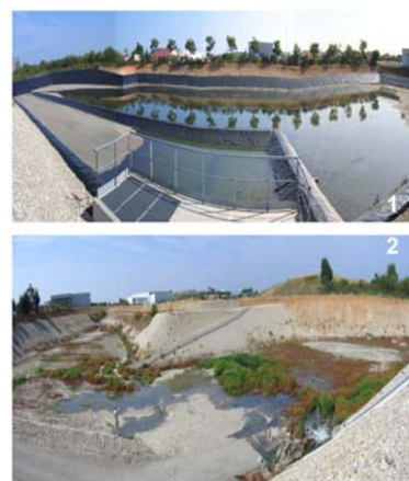
Figure 2-2. Bassin de rétention (1) et Bassin d'infiltration (2) du site Django Reinhardt.
