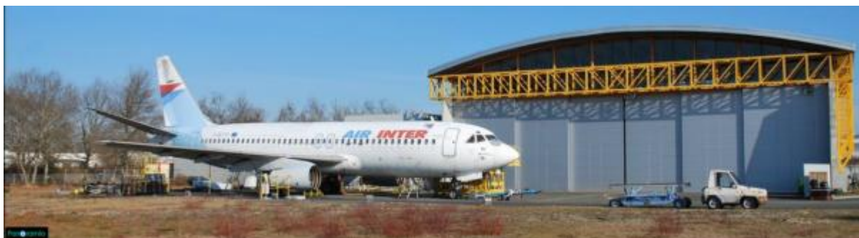
Figure 2. 5 : Le hangar du site d'IMA
