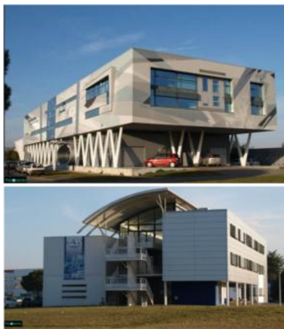
Figure 2. 7 : Les façades nord-ouest (en haut) et sud (en bas) du bâtiment du DUSA
