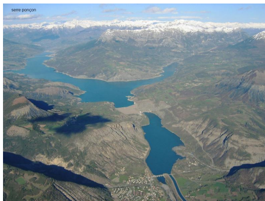
FIGURE 2.2 – Barrage de Serre-Ponçon. La retenue est alimentée par la Durance et l’Ubaye. La réserve de Espinasses peut être observée dans le bas de la photo. Cette retenue est le point de départ du canal usinier EDF sur la branche Durance. Photo : ‘Camille Sim’
