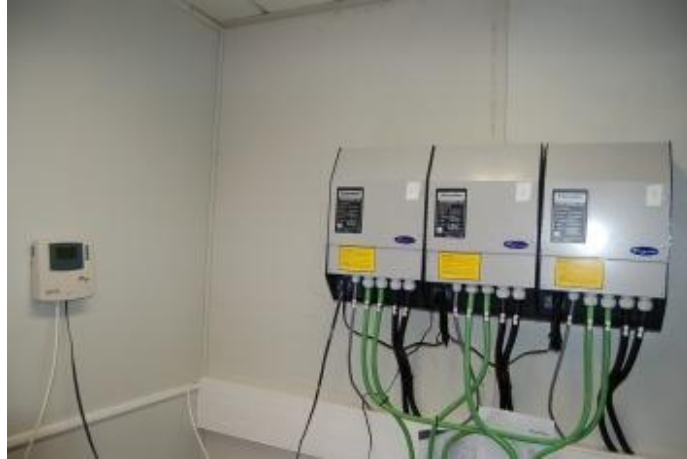
Fig 5-84: Installation de la télécommande et des onduleurs Studer en triphasé
