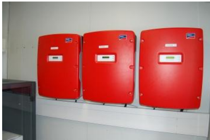
Fig 5-85: Installation des onduleurs SMA en triphasé
