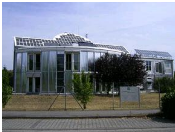
Fig 1-47 : Maison énergétiquement autonome de Freiburg
