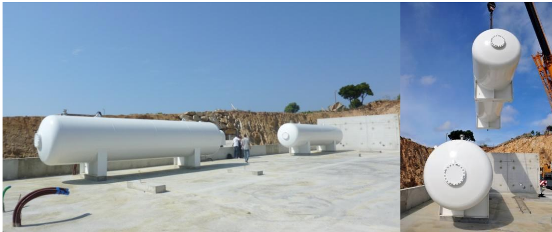
Fig 1-60 : Installation des réservoirs sur le site de stockage des gaz
