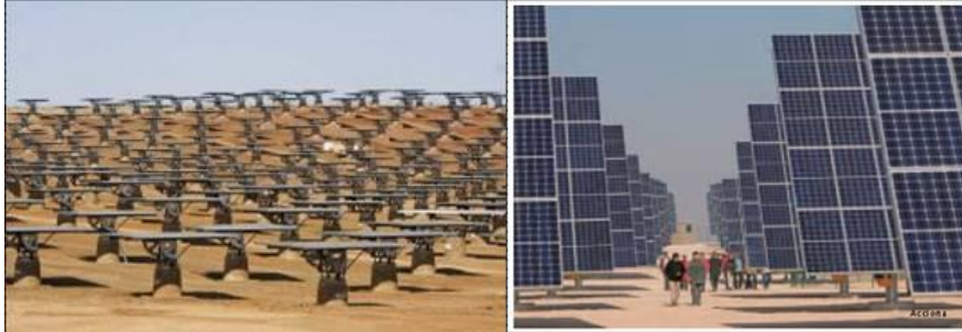
Fig 1-11 : Solar Parc EXTremadura (SPEX) : 30MWc et Bavaria : 14MWc
