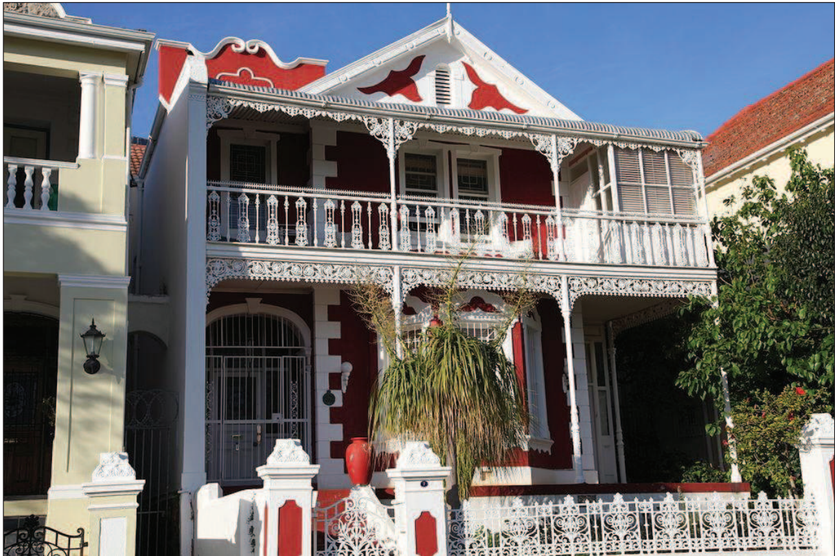
Fig. 34 : Bâtisse localisée au 7 Belvedere Avenue, Oranjezicht, Cape Town, construite entre 1900 et 1905, avec son stoep .
