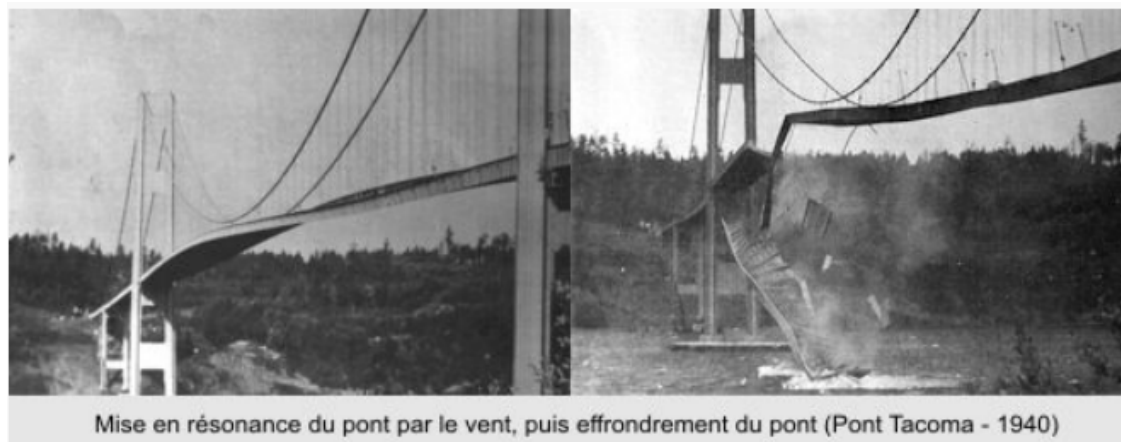
FIGURE 1.6 – Effondrement du pont de TACOMA (U.S.A.) le 7 novembre 1940 causé par un phénomène de résonance dû aux oscillations en torsion provoquées par le vent.
