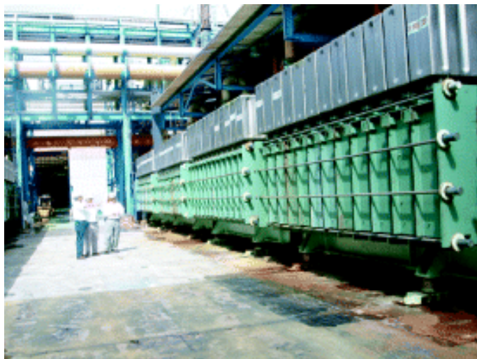
Figure 1.2 : Cellules d'électrolyse Chlore-Soude (Millet 2008)
