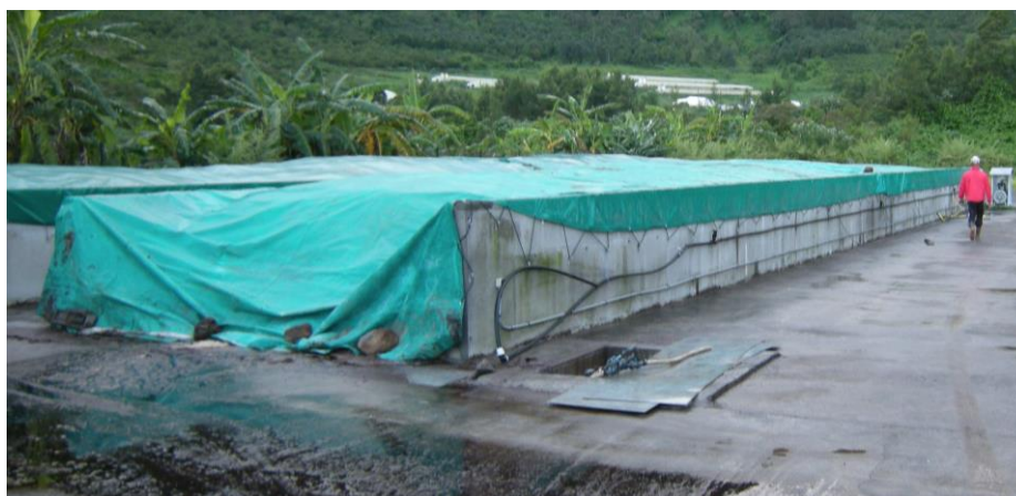
Figure 21. Silos de compostage Val'id® de Couvée d'Or
